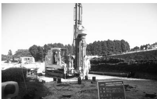
■杭打機DHJ-12での施工風景
