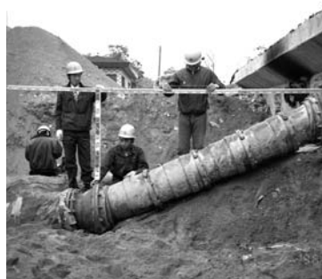
■ダクタイル鑄鉄製耐震用継手「フレキベンダー」
